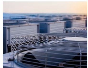
Ventilador Bomba de agua Compresor de refrigerante
